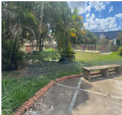
Armação da fundação da torre de treinamento Autoria: Maria Ribeiro Data: 18/11/2025
